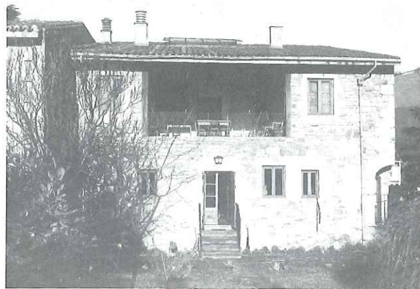
Fachada posterior de «Larreategi»
