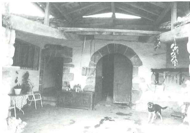
Detalle de la entrada de «Ibarguen torrea», en Urkizuaran
